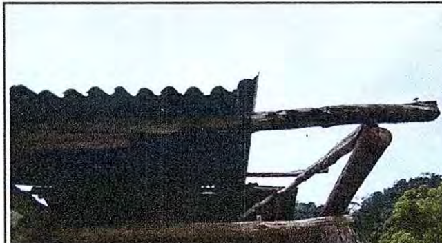
Foto 4: Se puede observar la parte de atrás de la Cocina del Centro Educativo el deterioro de las laminas y las vigas de madera.
