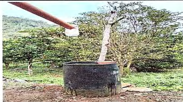
Foto 2: En esta fotografia se observa el Deposito del agua del Establecimiento donde se verifica el deterioro del tonel y por ende el cambio y sustitucion.
